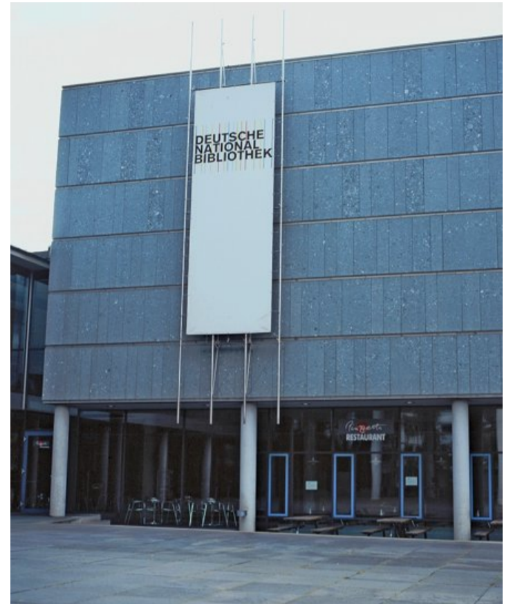
Le «vert de Salvan» recouvre la Bibliothèque nationale de Francfort, en Allemagne.
