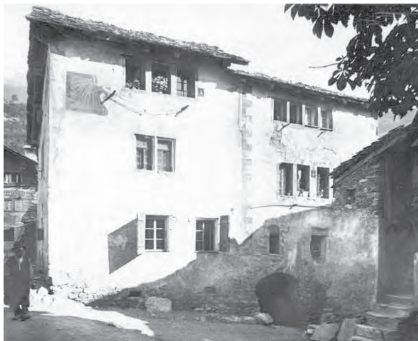
13 / Maison de Platea, façade sud, avant restauration : l'entrée principale basse entre les deux parties, accès principal dès 1597, mène à l'escalier en vis qui distribue sur les deux corps. Les façades portent l'empreinte des travaux du XVIII e siècle, avec les chaînes d'angle peintes substituées à celles du XVI e ainsi que le cadran solaire éliminé en 1978-1980, relevé puis reporté en deux exemplaires sur la maison Monderessy dans la foulée.
