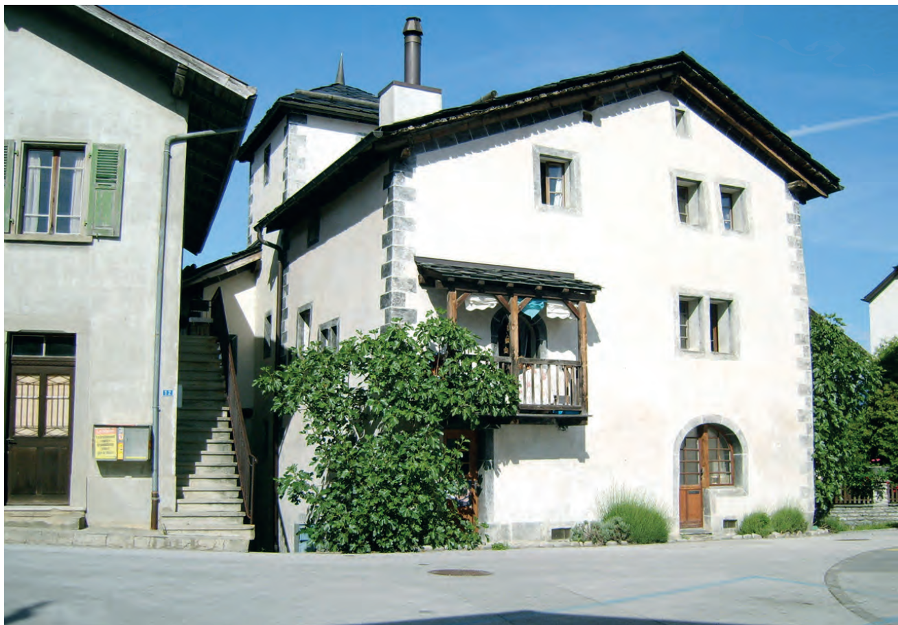
12 / Maison de Platea, 1542, 1597 et 1719, à l'est de la place du village, état actuel du côté ouest : une poterne découverte et rouverte lors de la restauration de 1978-1980, à peine visible sous la couverture du balcon, ravive le souvenir d'un édifice antérieur, tour ou maison forte ; en bas à droite, porte et arc d'une ancienne porte d'entrée. À gauche une partie de la "Coopé".
